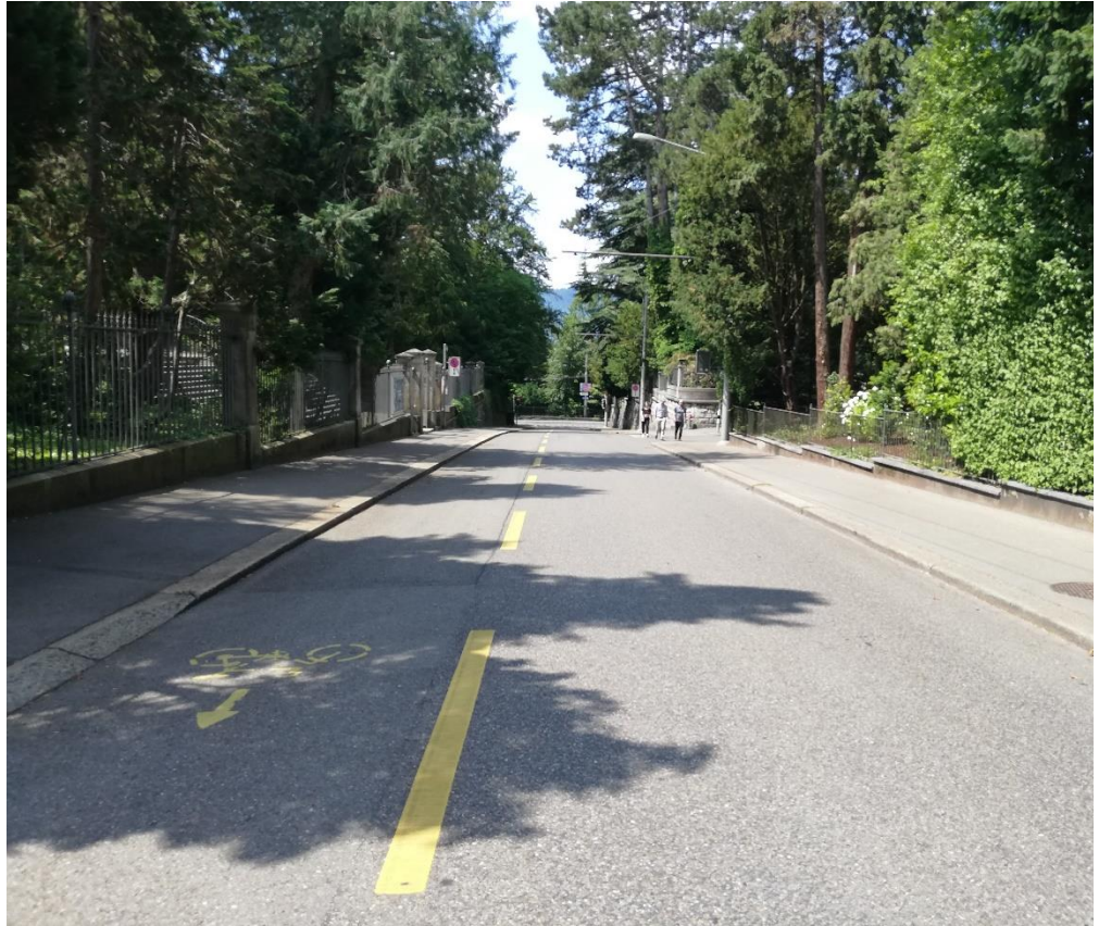
Westlicher Abschnitt mit Blick Richtung Zollikerstrasse
